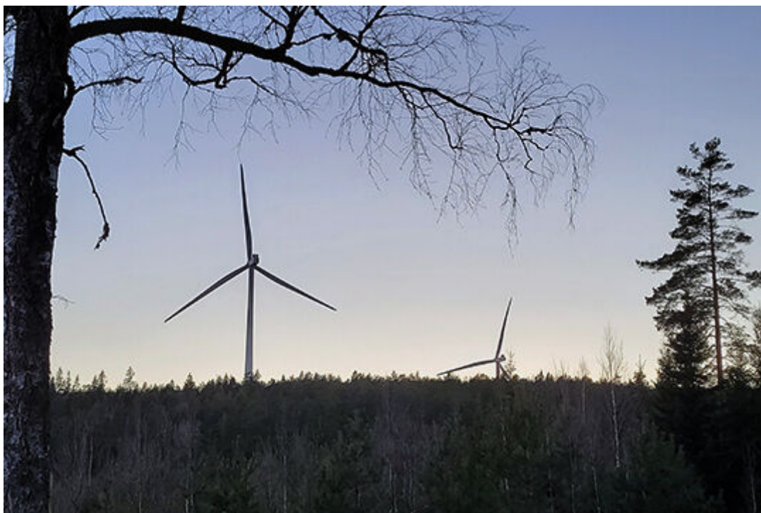
Vindkraftverk i Munkhyttan. Foto: Fredrik Norman
