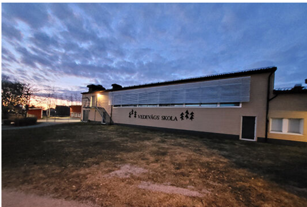
Vedevågs skola. Foto: Fredrik Norman
