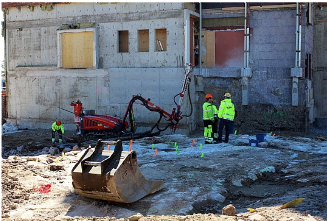
Sprängning av berg pågår vid Lindesbergs lasarett. Foto: Ida Lindkvist
