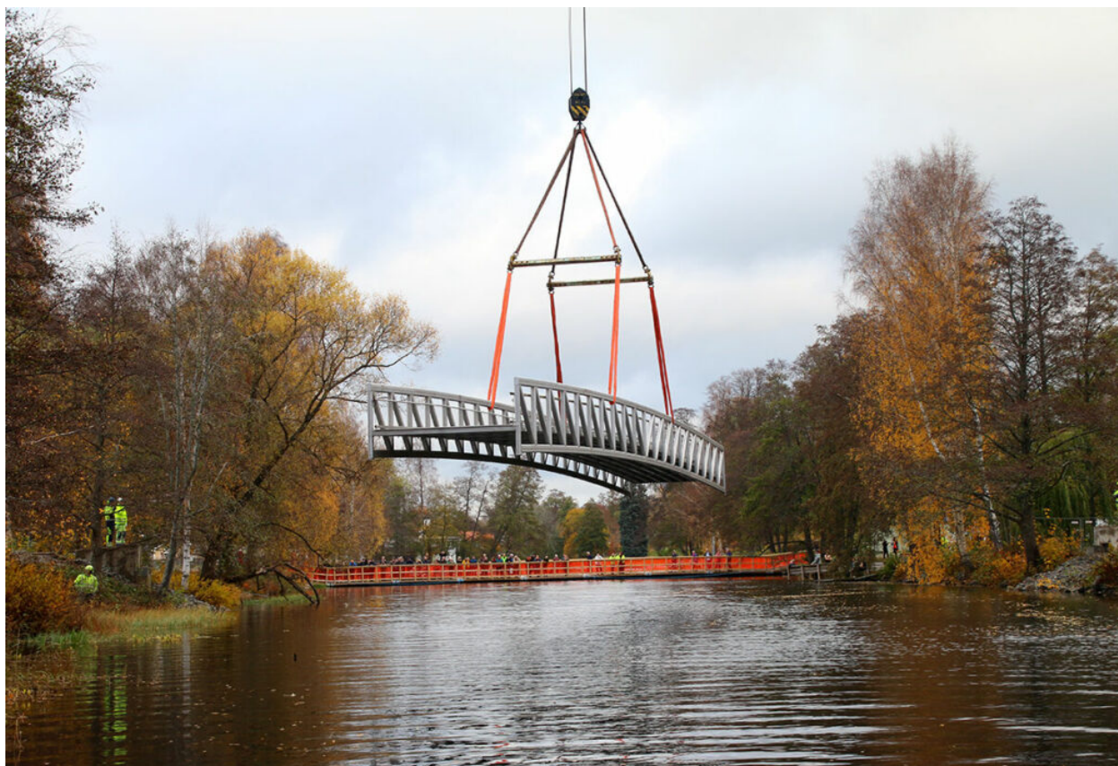
Västra Loppholmsbron lyfts på plats. Foto: Jennie Einarsson
