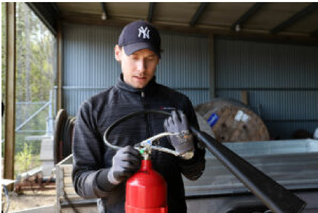
Viktor Folkesson från Brandservice visar hur de besiktar brandsläckare. Foto: Camilla Lagerman
