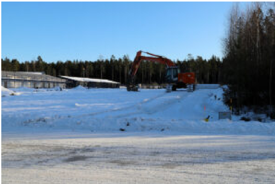
Byggmax nya varuhus kommer att byggas på Stafettgatan, intill Lindesbergs Fastigheter. Foto: Camilla Lagerman
