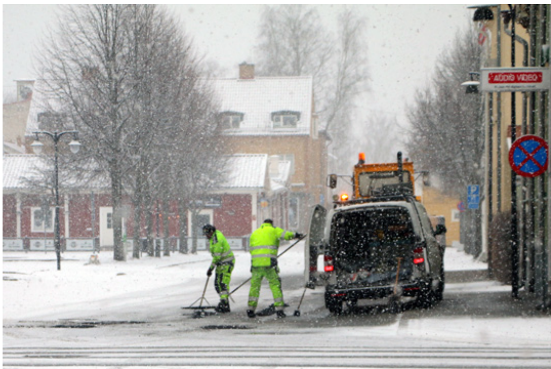
Här fylls potthålen igen på Smedjegatan. Foto: Fredrik Norman
