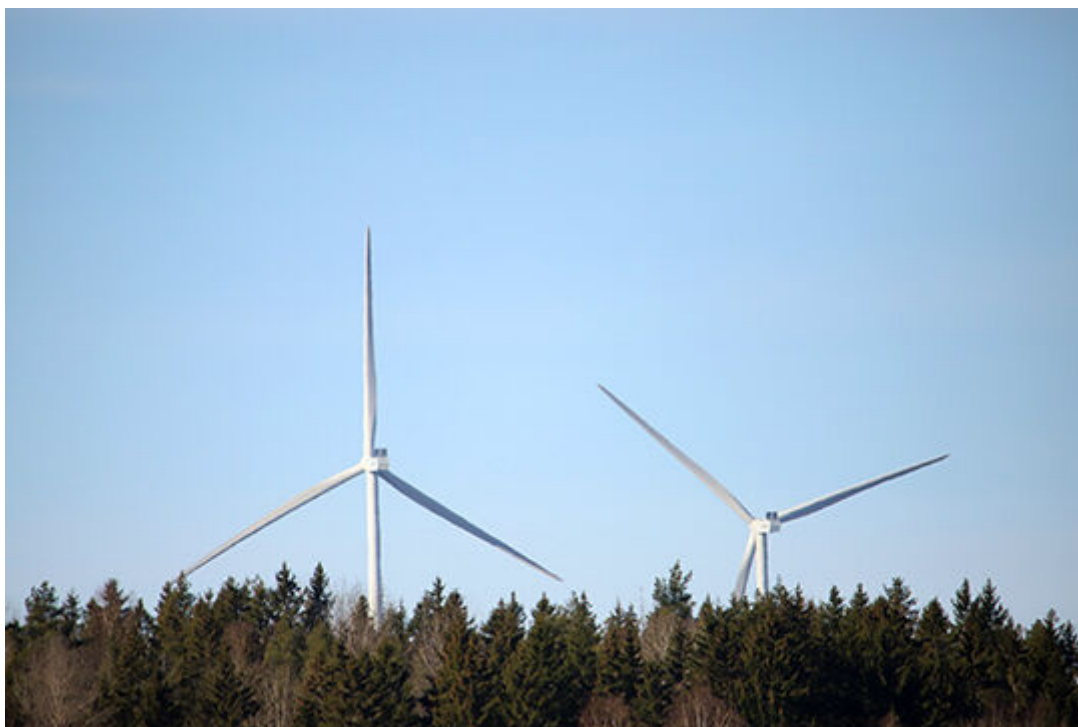
Vindkraftverk i Munkhyttan. Foto: Fredrik Norman
