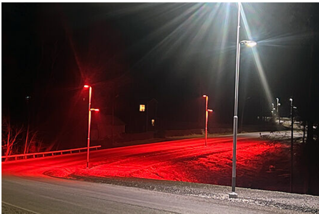
Den nya iögonfallande belysningen finns där av en anledning. Foto: privat
