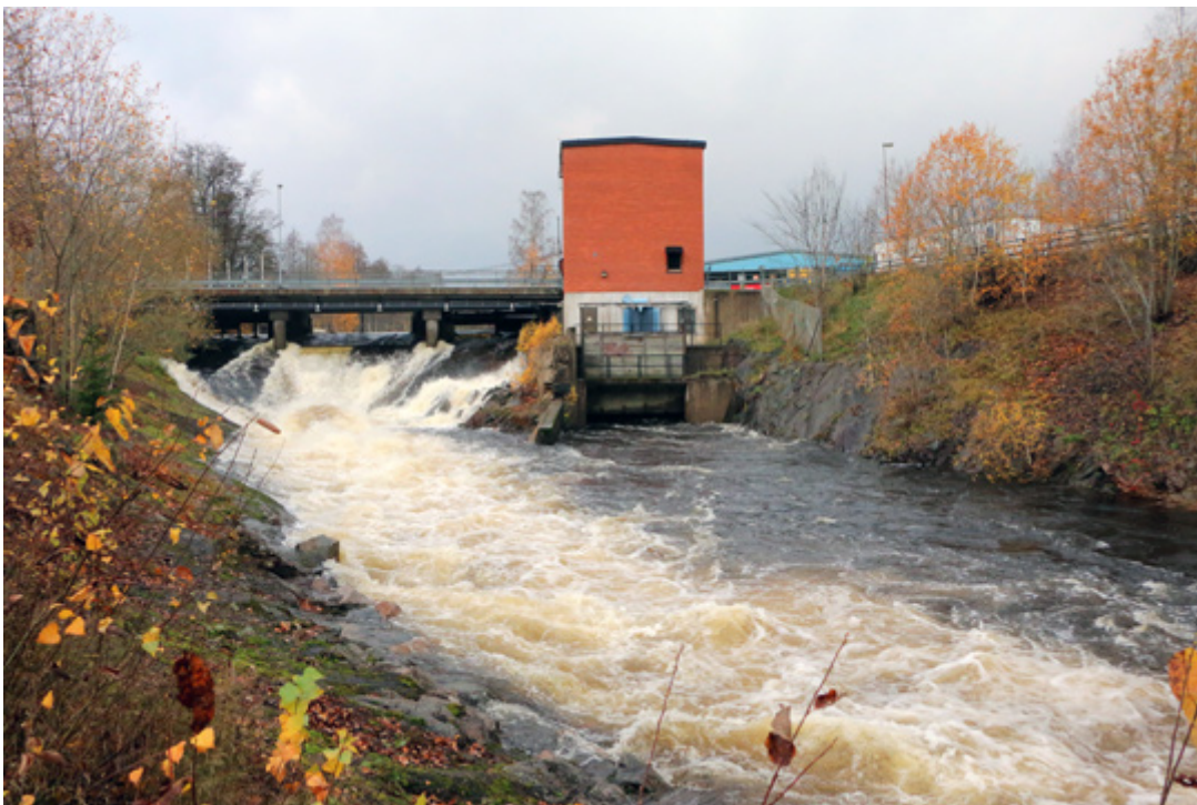
Vattenmassorna dånar fram vid kraftstationen i Dalkarlshyttan. Foto: Fredrik Norman
