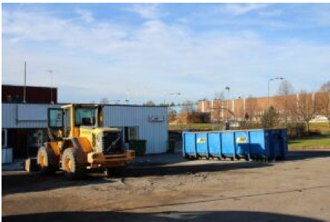
Renoveringen är i full gång i den nya lokalen. Foto: Camilla Lagerman
