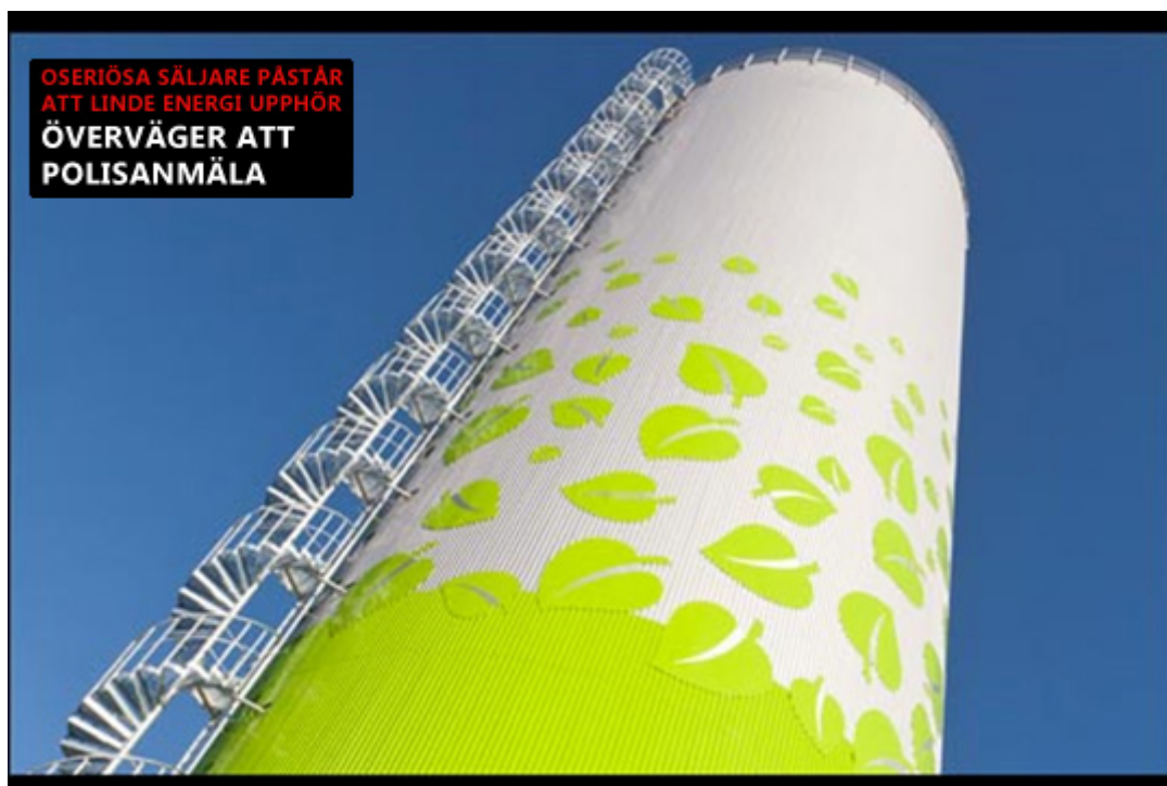
Foto: Linde Energi
