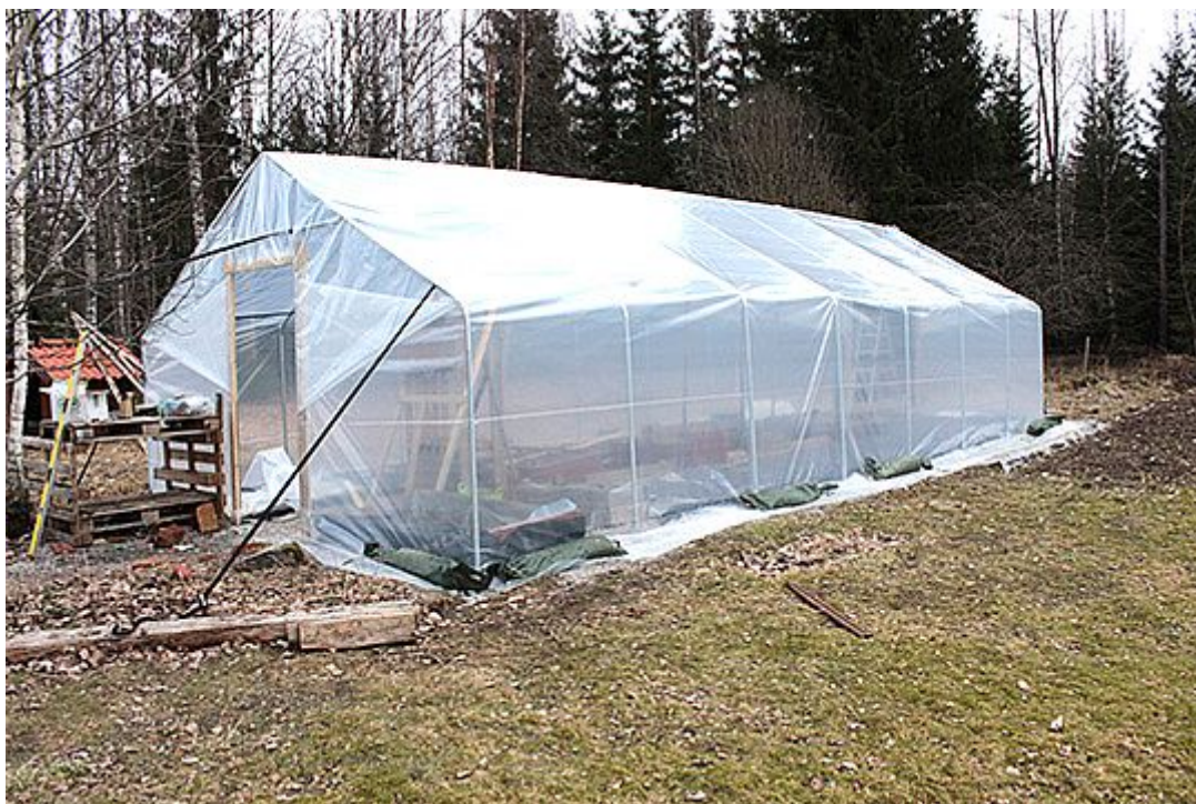
Växthuset är konstruerat av ett sinnrikt system av stål bågar och plast. Foto: Gjordnära
