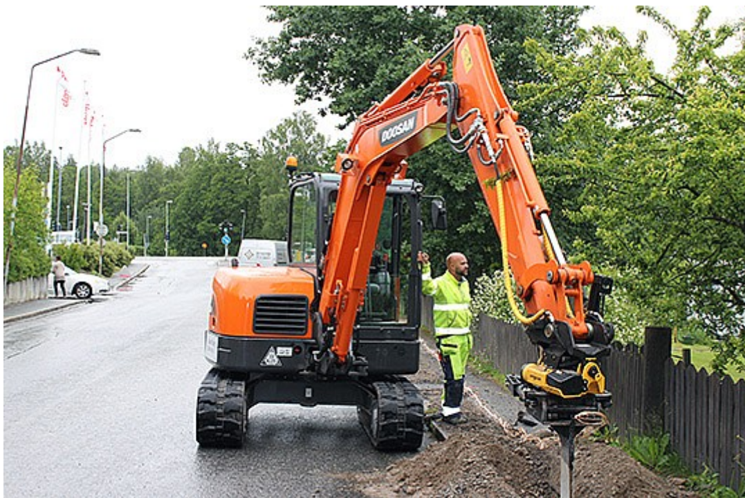
Här grävs huvudledningen för bredband, som sedan kan anslutas till intresserade villaägare. Foto: Hans Andersson
