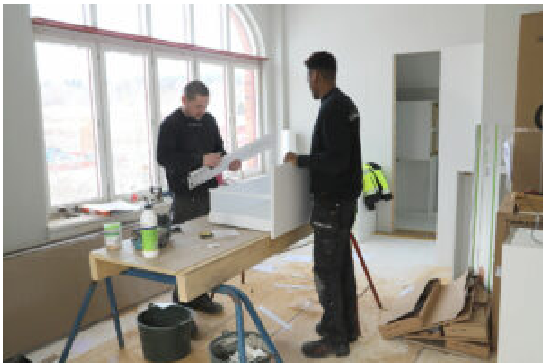
Johan och Aron monterar det 17:e köket i byggnaden. Foto: Camilla Lagerman
