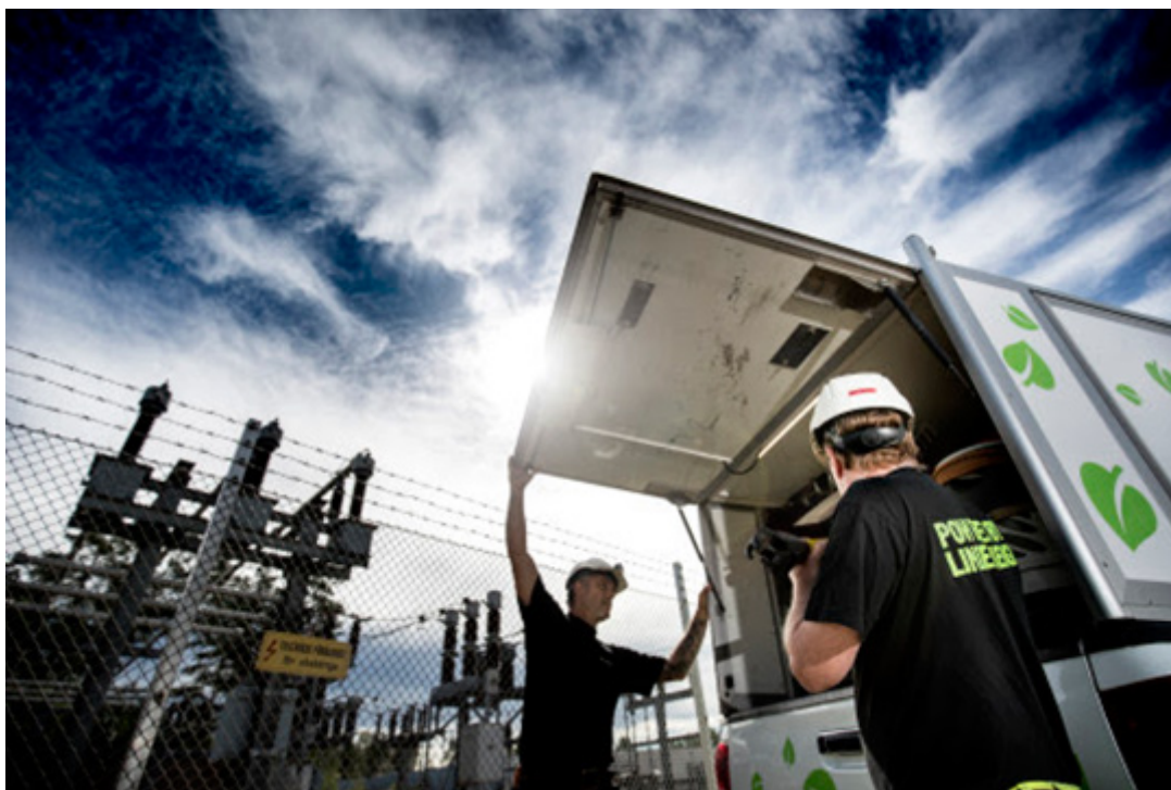
Foto: Linde energi
