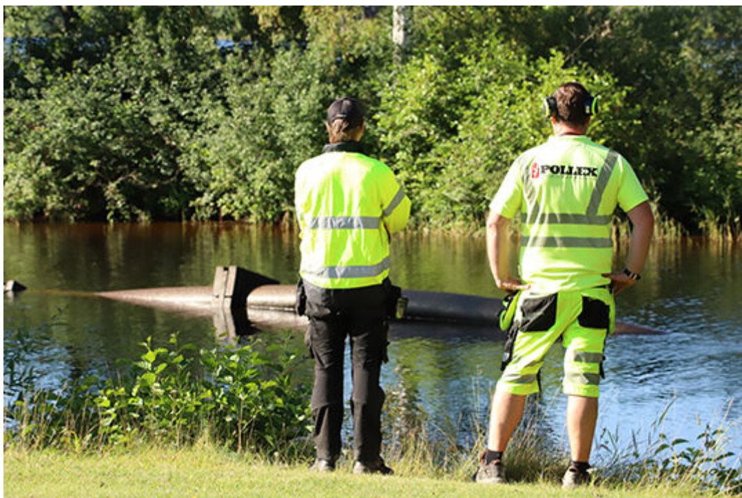
Ytläge för avloppsledning åtgärdas. Foto: Fredrik Norman
