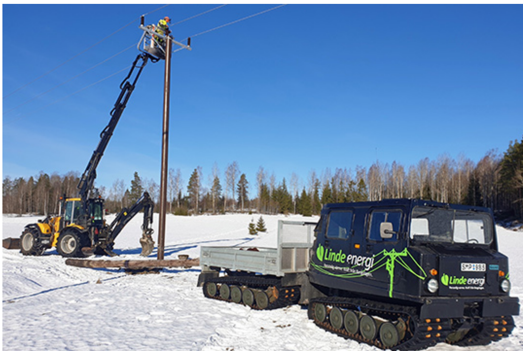
Drygt en mil luftledning uppgraderas. Foto: Linde energi.
