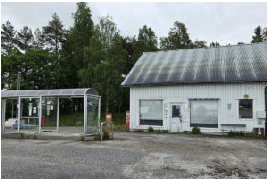
Så här såg fastigheten ut före det omfattande arbetet med att rusta och anpassa för nytt ändamål. Foto: Privat
