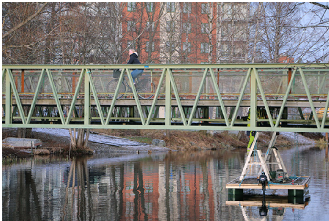
Sedan några dagar tillbaka har man arbetat med att förstärka den försvagade bron över ån. Foto: Fredrik Norman
