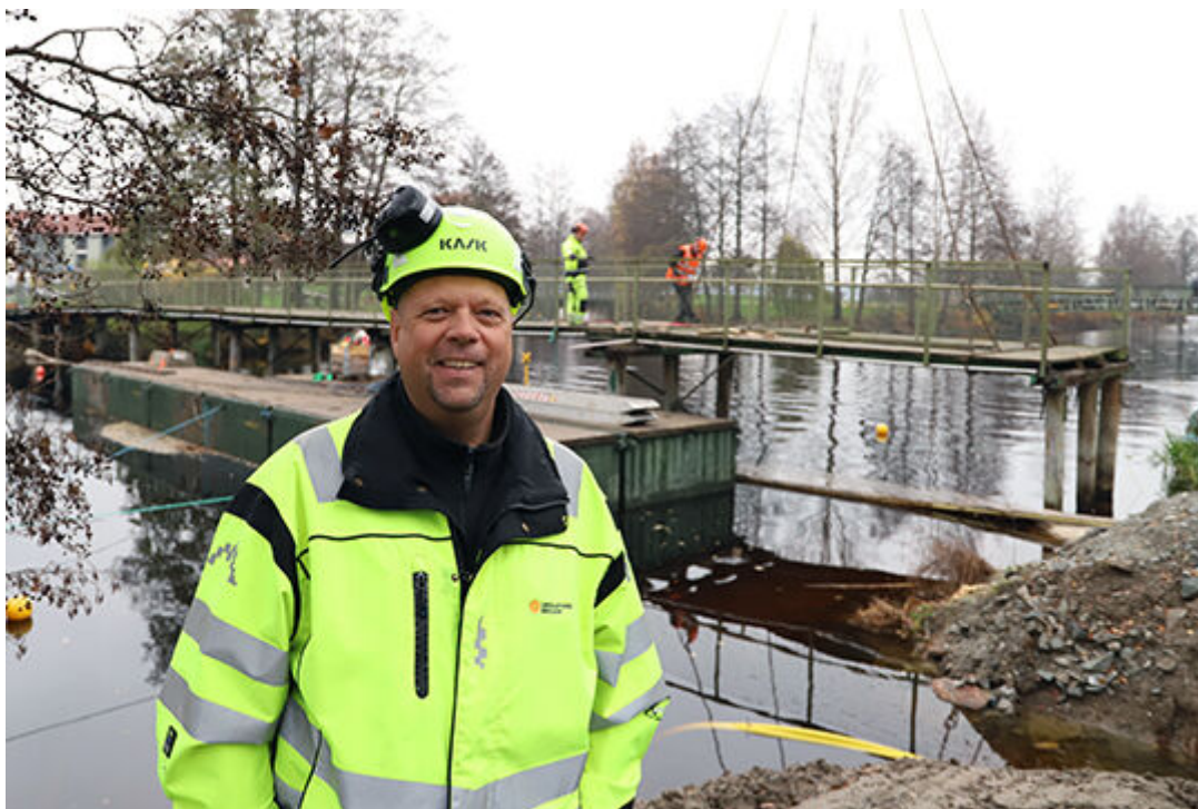
Jan Fredriksson, projektledare på Samhällsbyggnad Bergslagen, med den utdömda bron bakom sig. Foto: Fredrik Norman
