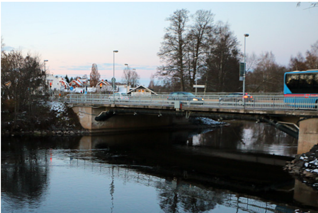
Prästbron skall renoveras och i samband med det hoppas man även få pengar till en ny trafiksignalanläggning. Foto: Fredrik Norman
