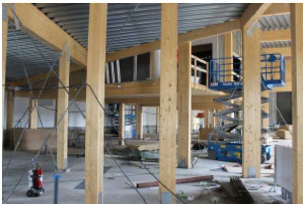
Många pelare och olika vinklar i den nya brandstationen. Foto: Hans Andersson
