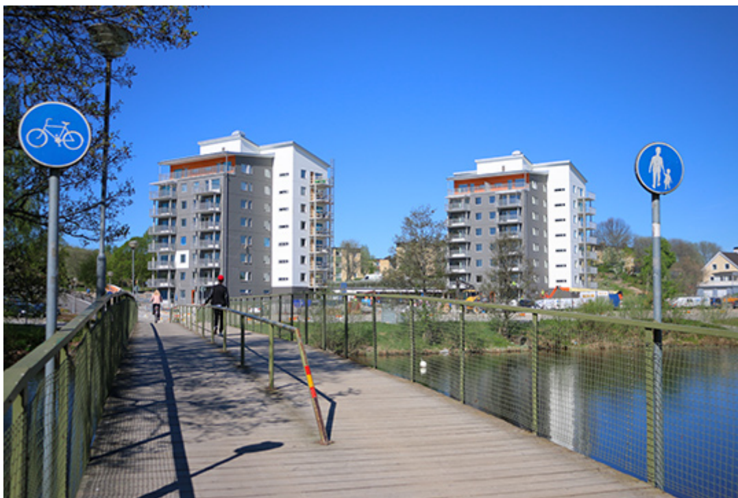
Nu skall Åkilsbackens norra hus fyllas med hyresgäster. Hyresgästerna i det södra huset, närmast Lindesberg Arena, får tillträde i augusti. Foto: Fredrik Norman
