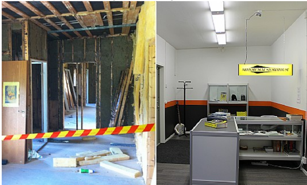
Butiksdelen, före och efter renovering
