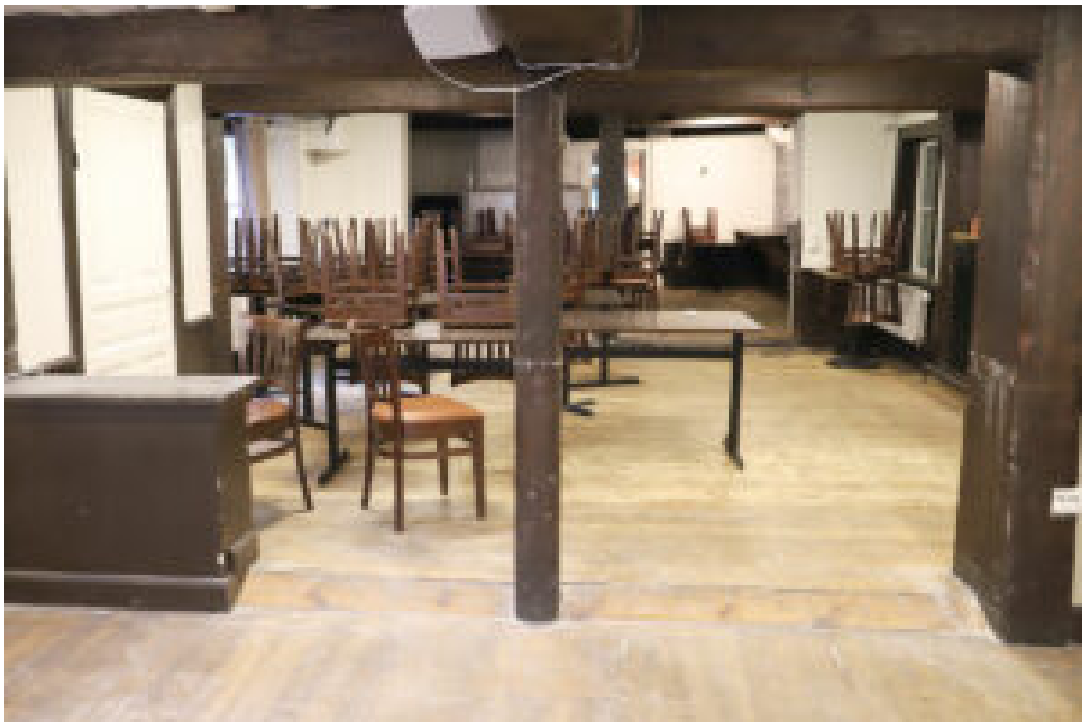
Arbetet pågår för fullt. Foto: Camilla Lagerman
