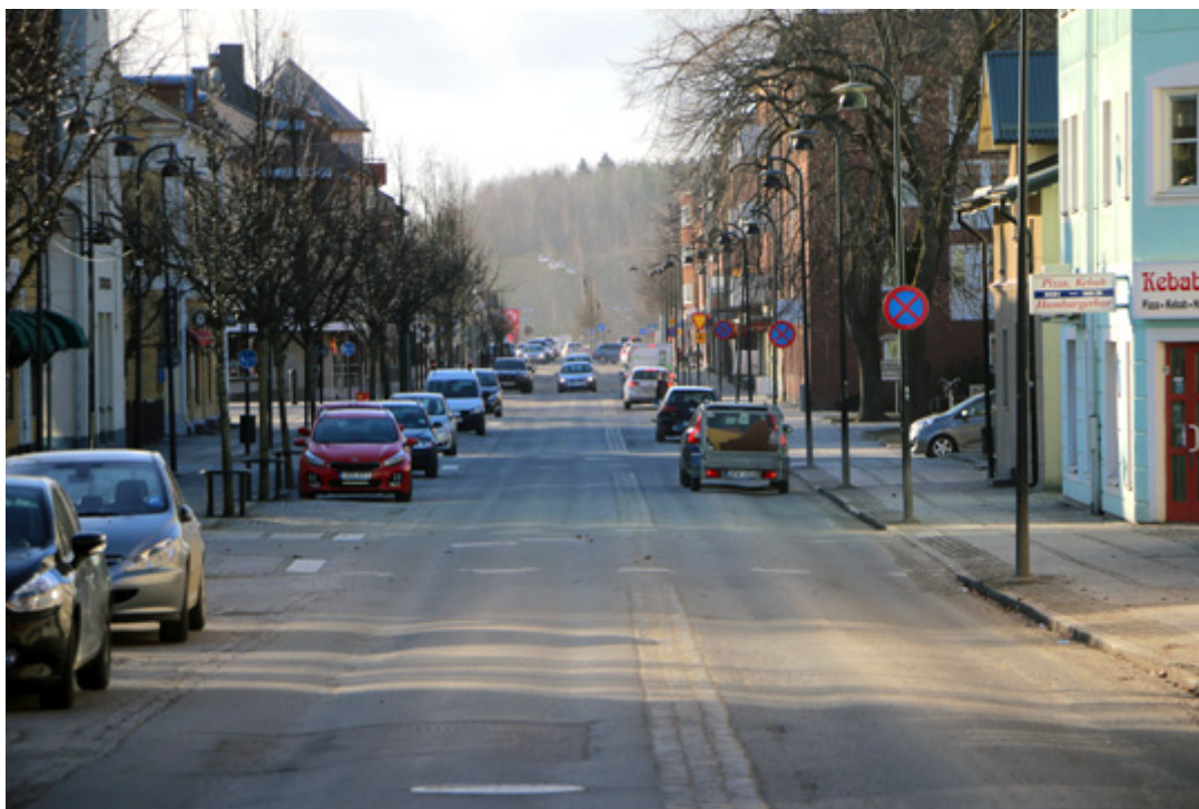
Kristinavägen i Lindesberg är i stort behov av underhåll. Foto: Fredrik Norman
