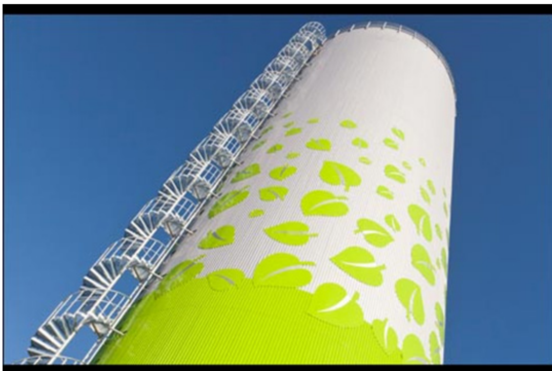
Foto: Linde Energi
