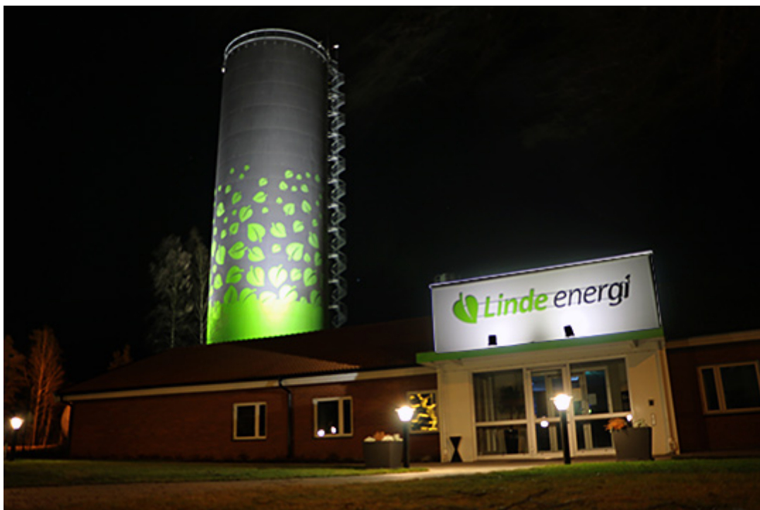
Sedan i december ger Linde energis stora ackumulatortank ett konstnärligt intryck i mörkret. Foto: Fredrik Norman
