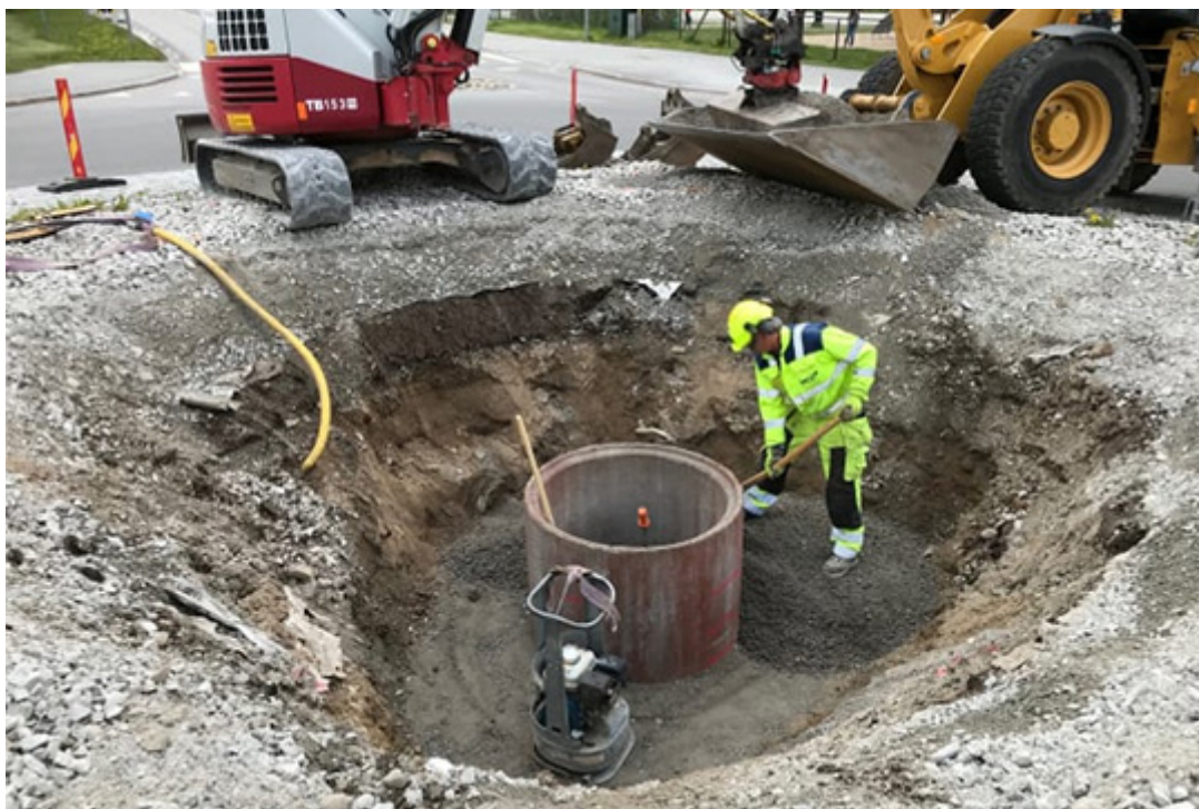
Förarbete inför installationen av konstverket och industriminnet TURBIN pågår i södra rondellen. Foto: Linde energi
