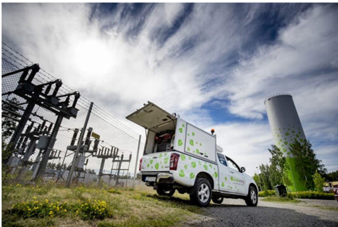
Foto: Linde energi
