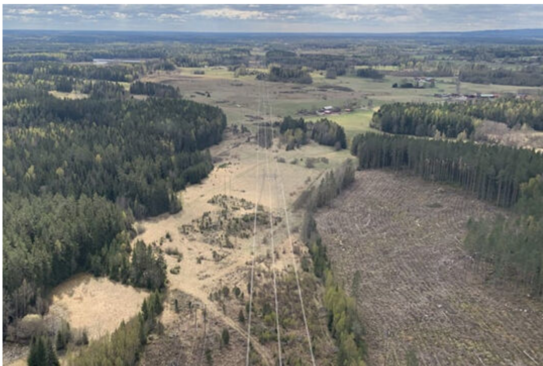
Foto: Linde energi
