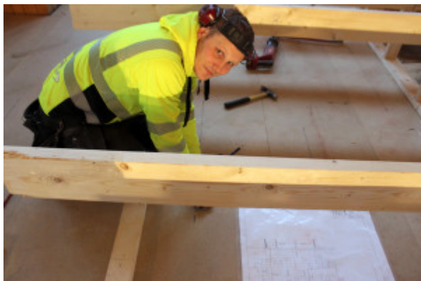
Erik Svensson sågar till en rejäl öppning för den bashögtalare som ska installeras i scengolvet. Foto: Hans Andersson
