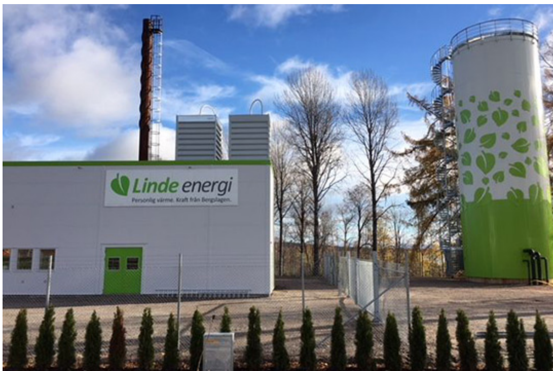
Linde energis nya fjärrvärmeanläggning i Guldsmidshyttan är redo att leverera. Foto: Linde energi AB
