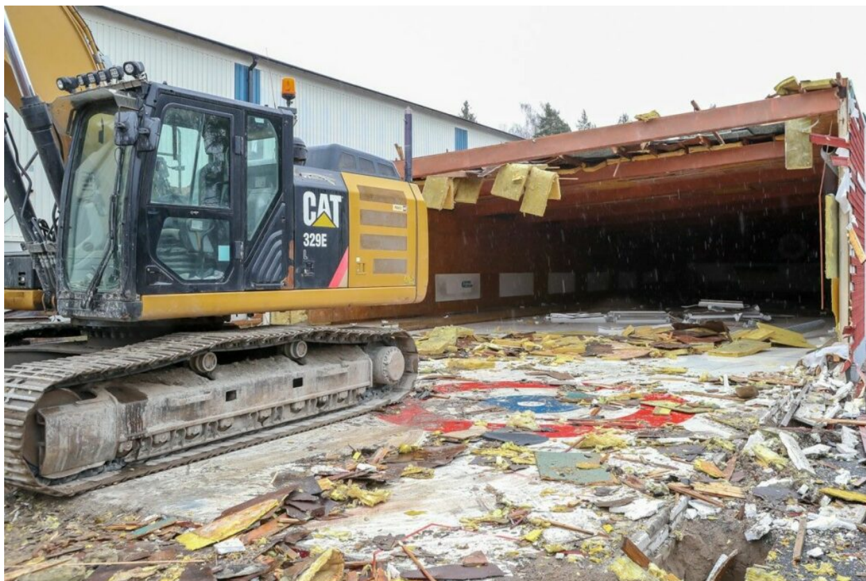
Rivningen är igång. I oktober beräknas en ny curlinghall att finnas på plats. Foto: Hasse Persson
