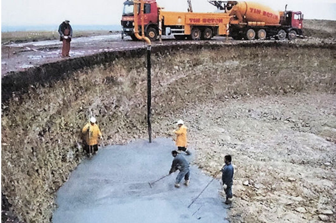
Pågående arbete med ett vindkraftverks fundament i Centraleuropa. Foto: Privat
