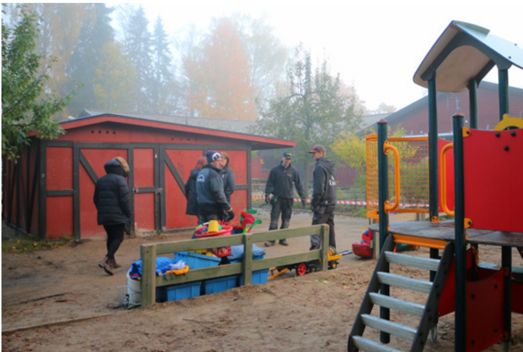
Förrådsbyggnaden inspekteras av representanter för fastighetsägaren, Libo, i sällskap med förskolepersonal efter gårdagens brand. Foto: Fredrik Norman
