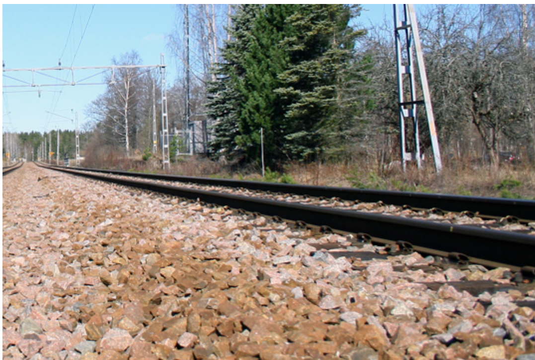
Sträckan Vedevåg-Lindesberg rustas nästa år. Foto: Fredrik Norman
