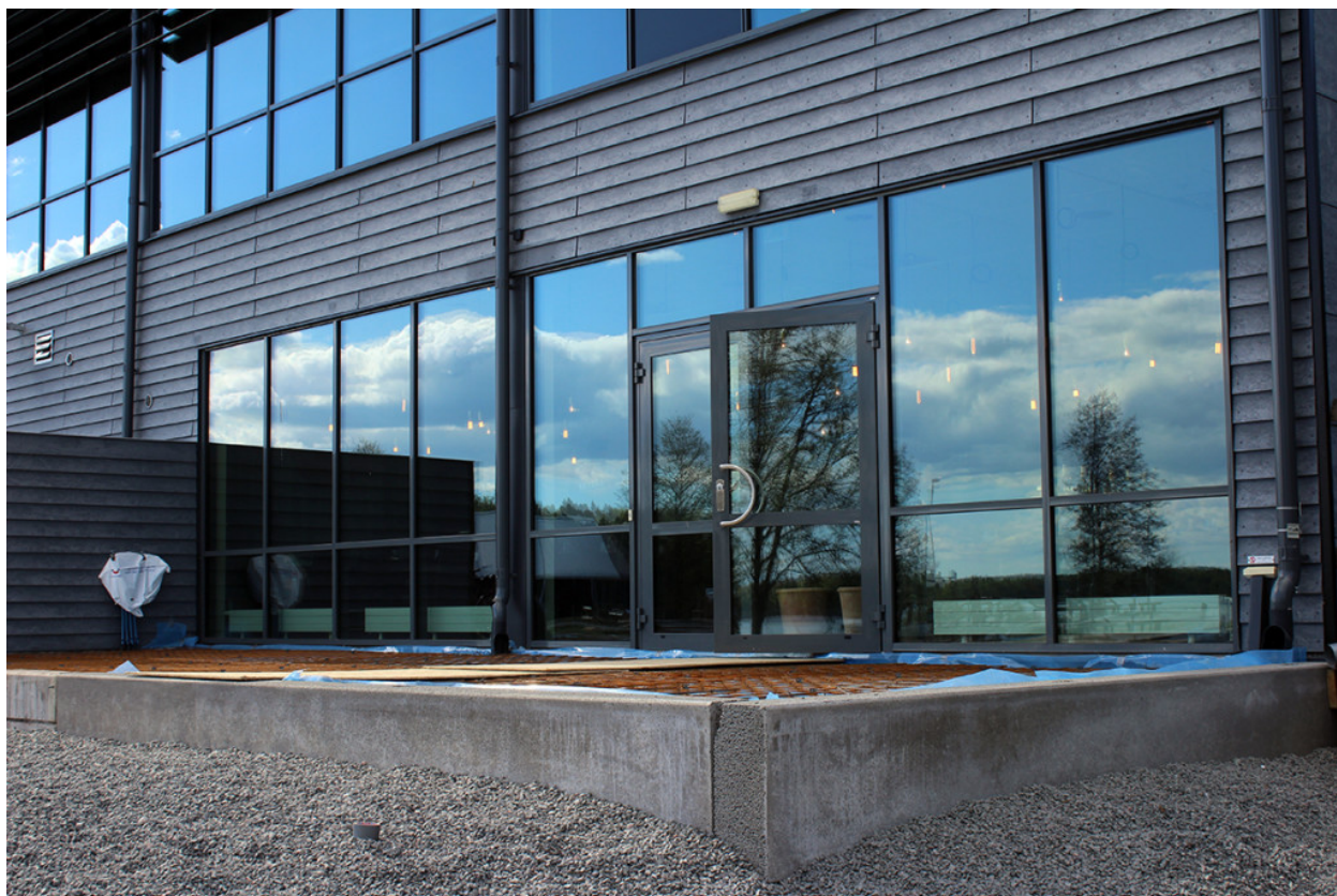
Här ska det nya uterummet byggas. Foto: Camilla Lagerman
