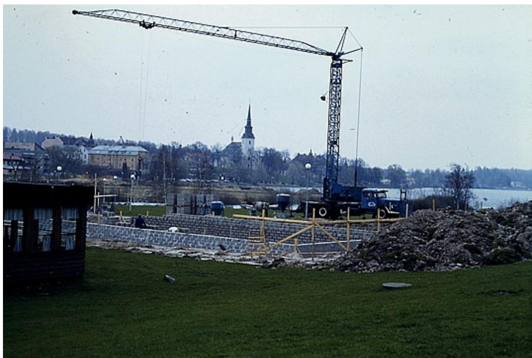
Gymnasisterna fick flytta ut från stan till Tredingsjorden, där byggkranar byggde en skolstad. Foto: Leif Kalmö
