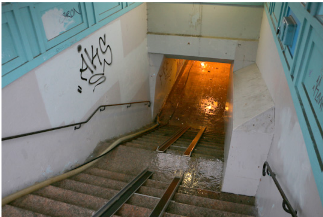
Järnvägstunneln spolas idag. Foto: Fredrik Norman
