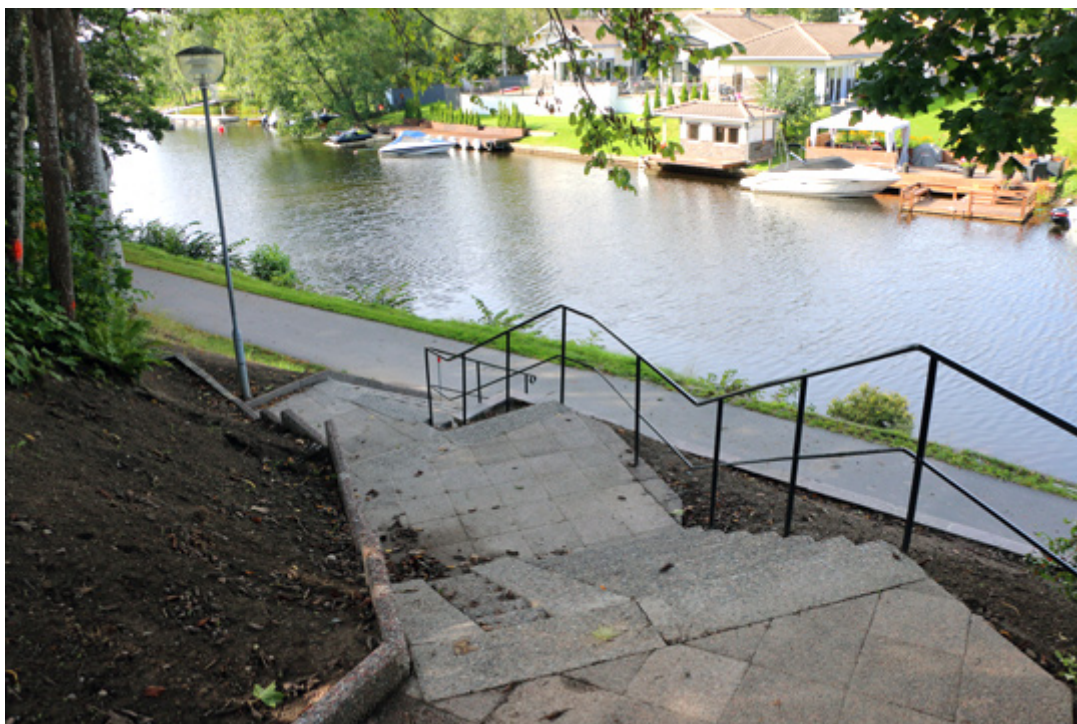
Den gamla stentrappan är i nyskick igen. Foto: Fredrik Norman
