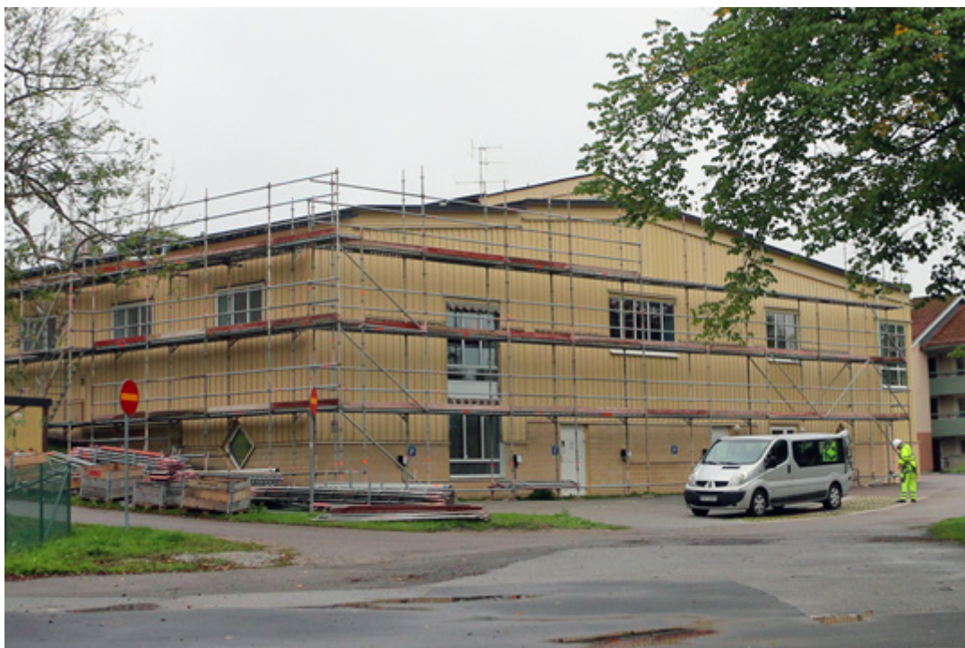
Badhuset Energikällan i Lindesberg får nytt tak. Foto: Fredrik Norman
