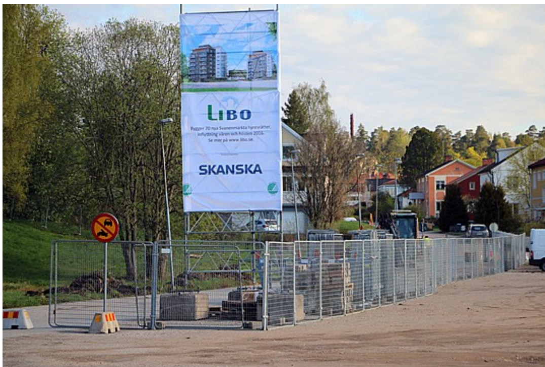
Lindagatan kommer öppnas för viss trafik under byggtiden. Foto: Fredrik Norman
