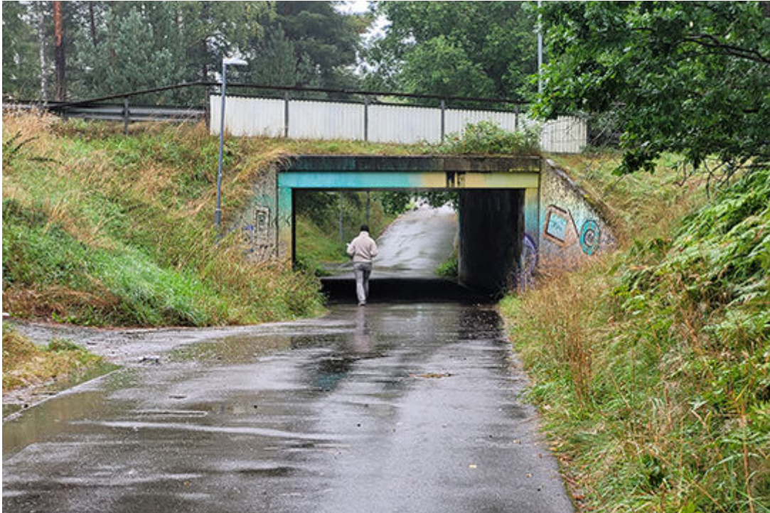
Tunneln under Bergslagsvägen. Foto: Fredrik Norman
