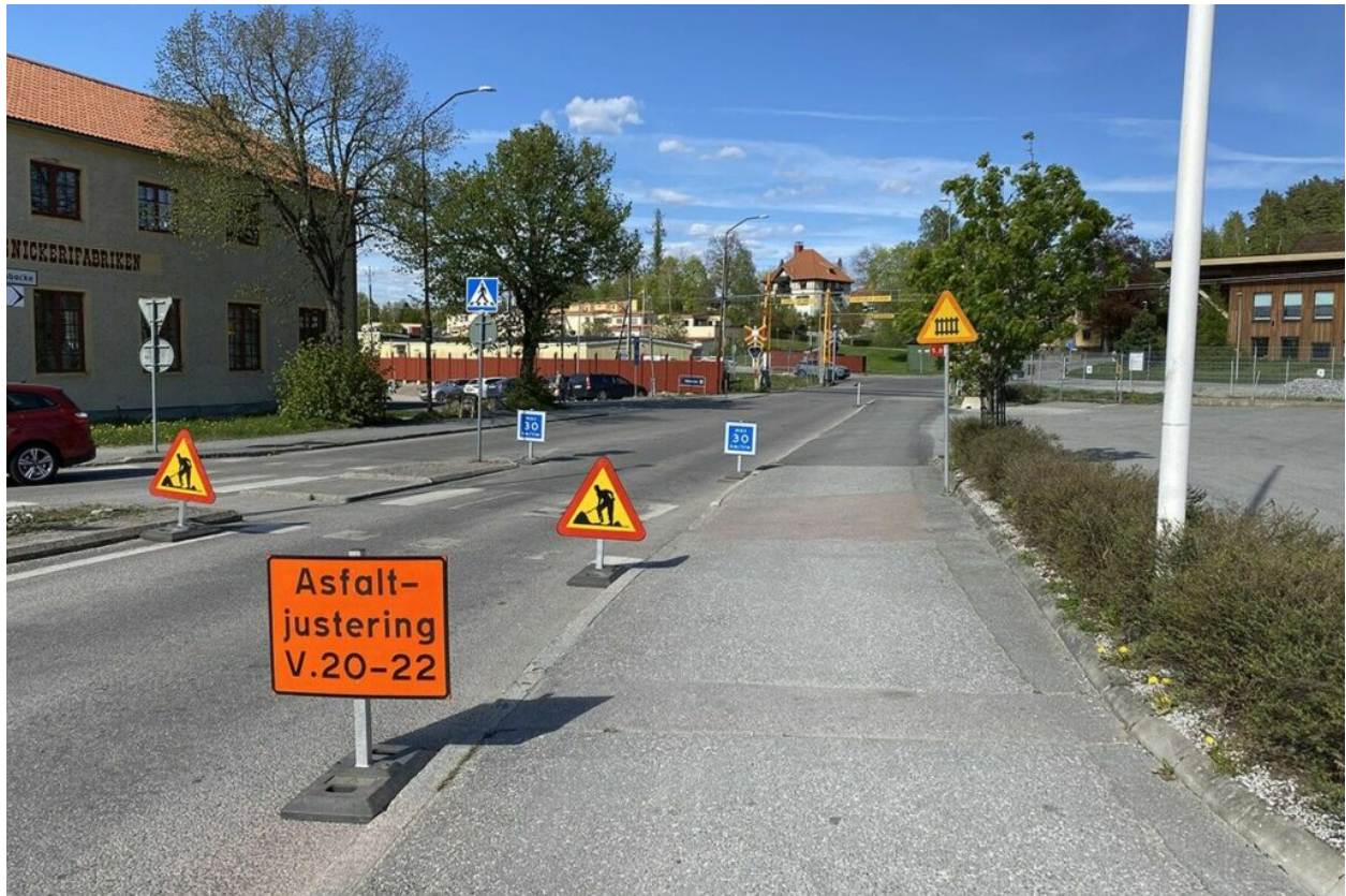
Nu startar asfalteringsarbetet på Schröders backe. Foto: Lindesbergs kommun
