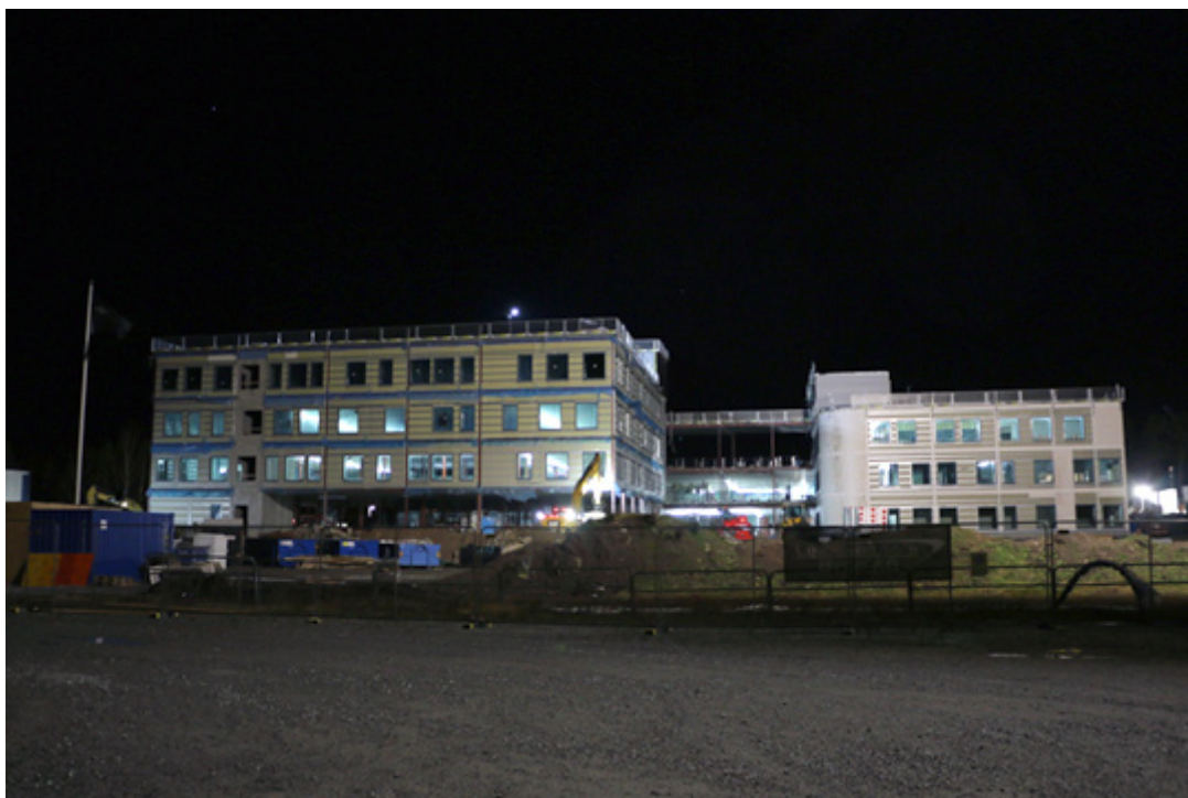
Ett inbrott på byggarbetsplatsen har upptäckts. Foto: Fredrik Norman
