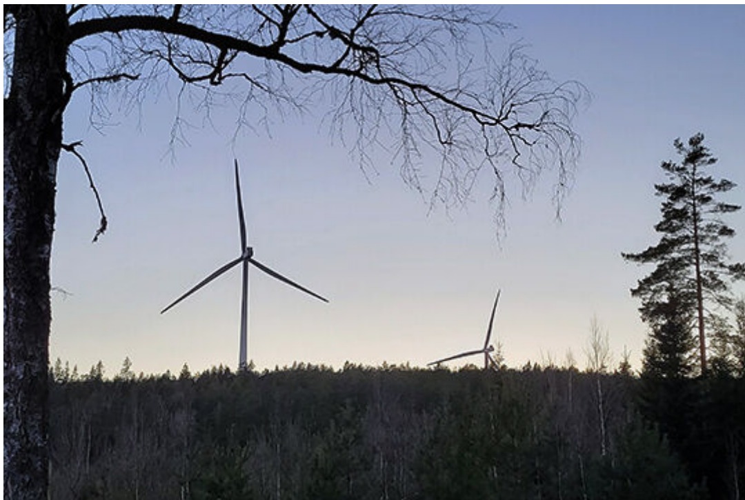
Vindkraftverk i Munkhyttan. Foto: Fredrik Norman
